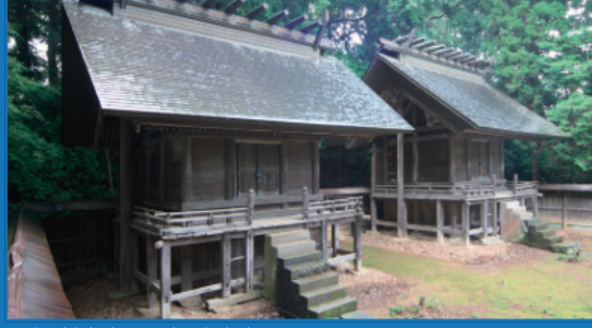
▲左:外宮本殿 右:内宮本殿
